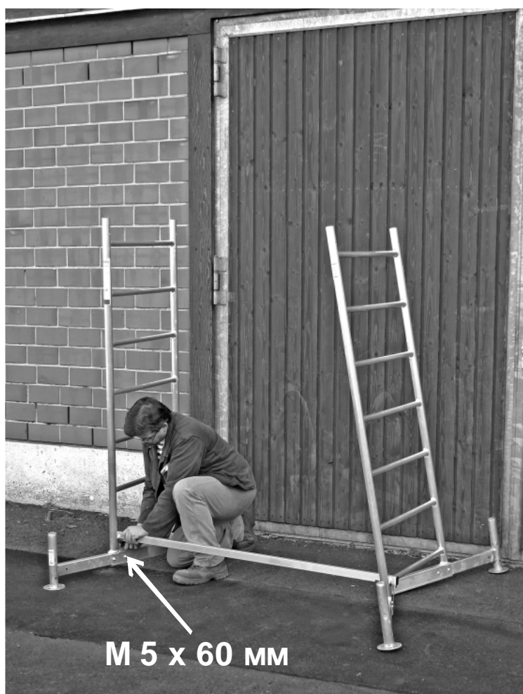
Базовая конструкция с первой надстройкой
