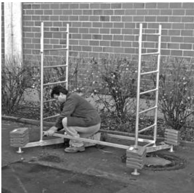
Базовая конструкция с первой и второй надстройками
