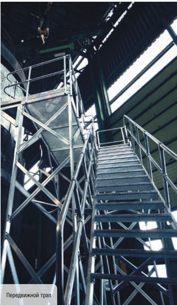
Передвижная рабочая площадка с окрашенным ограждением
